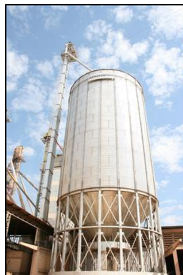
Figura 4: Silo (KEPLER WEBER 4 )
